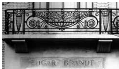
Ci-dessus: balcon de l'immeuble situé 101, boulevard Murat.
